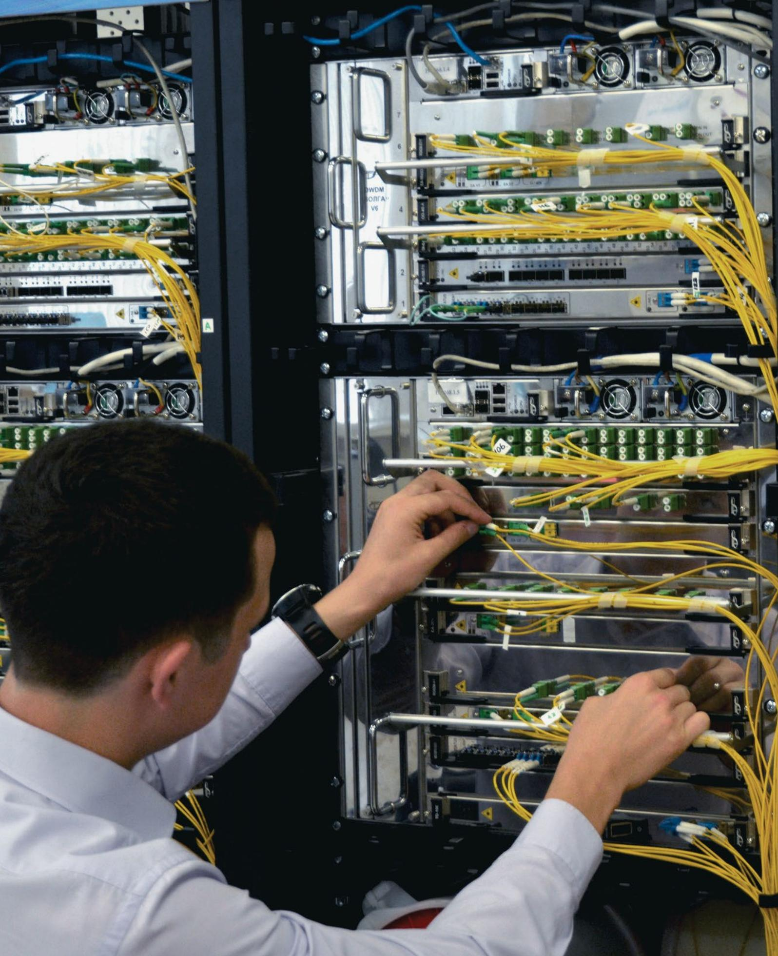
Благодаря технологии селективного переключения спектральных каналов (WSS) ROADM обеспечивает гибкое управление спектральными каналами и позволяет строить смешанные сети любой топологии. Узел ROADM может переключать спектральный канал на ввод/вывод и сквозную передачу без прерывания трафика.
